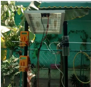
Fig. 7. Instalación del panel solar en espacio cerrado.
