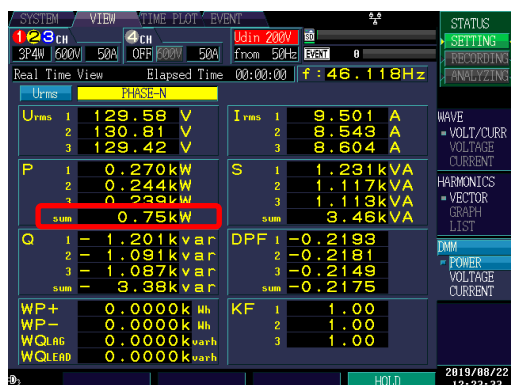
Fig. 9. Analizador de energía en generador. (Corriente y potencia escaladas 10 veces la medida real).
